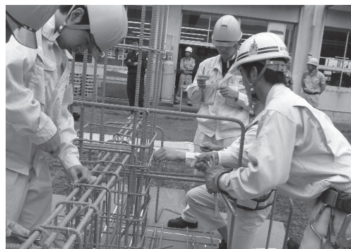
鉄筋組立ての実習風景
