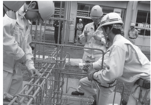
鉄筋組立ての実習風景
