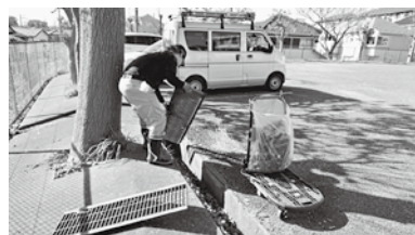
側溝の清掃：CMC 船橋
