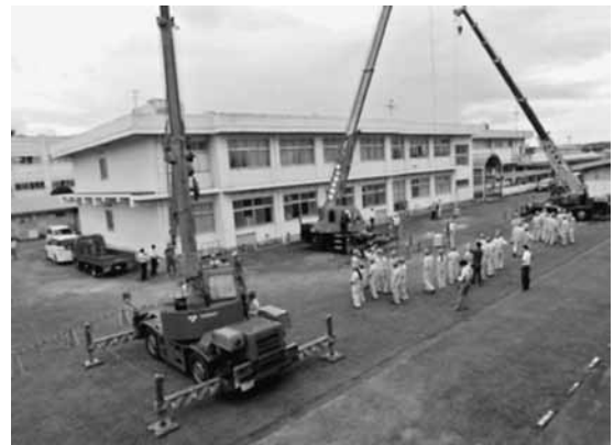
クレーン実習
