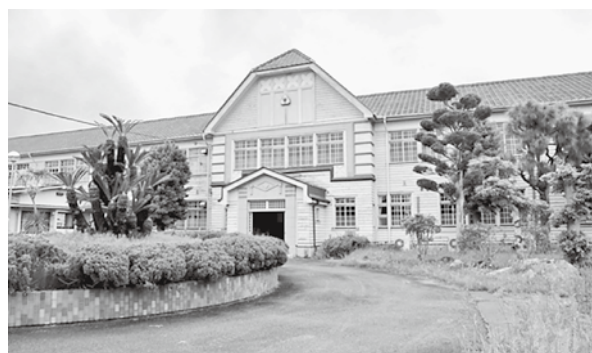
県立安房南高等学校旧第一校舎 外観
