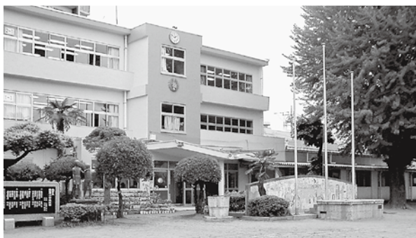
写真1 柏第一小学校校舎
